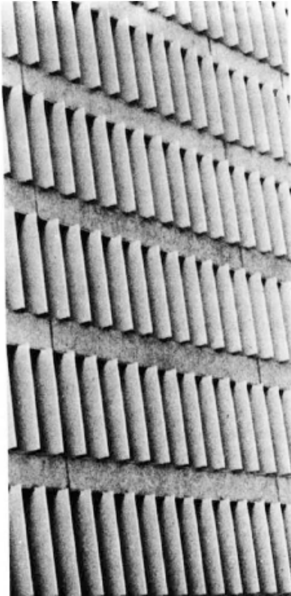
Protections solaires verticales (Afrique de l'Ouest)
