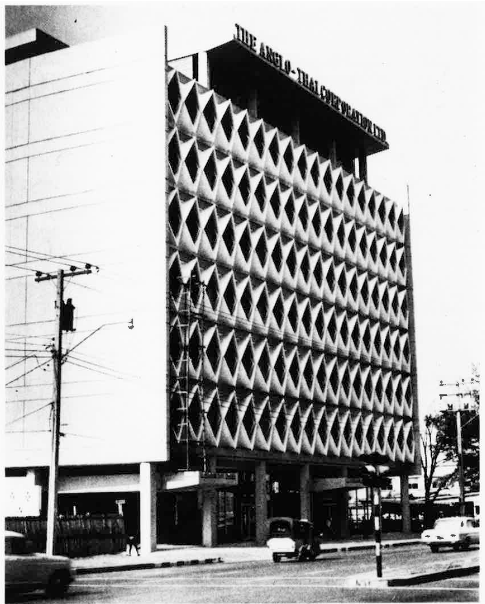
Protections solaires complexes (Thaïlande)
