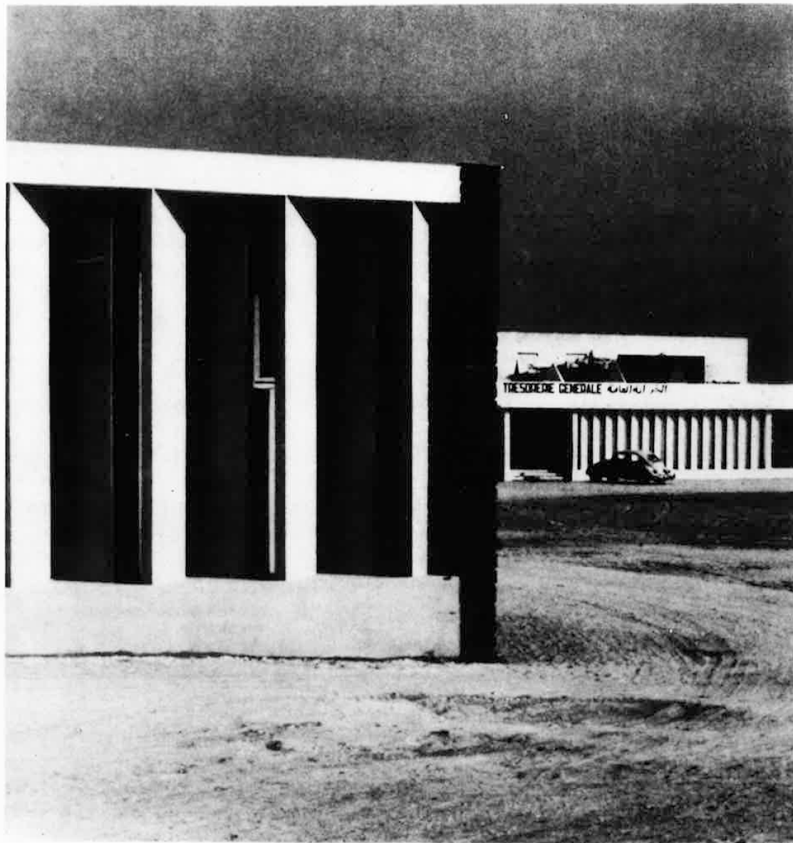
Protections solaires verticales (Afrique de l'Ouest)
